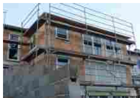
L'altalena dell'industria delle costruzioni nel 2023: pmi e misurazione dei rischi
