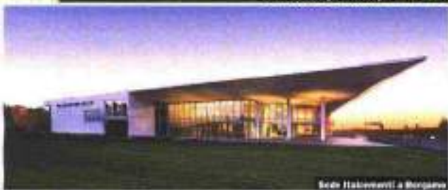
Sede Italcementi a Bergamo
