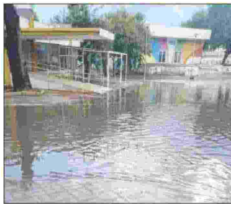
Uno degli allagamenti di ieri
